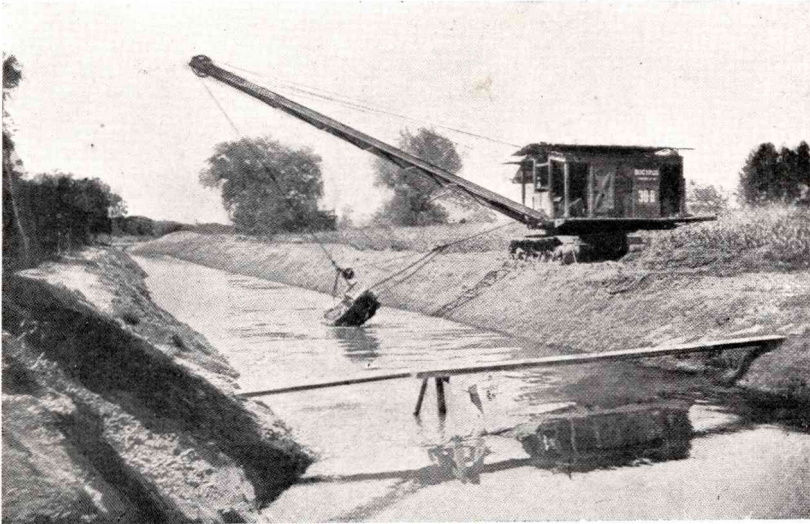
Fig. 11. — Una pala mecánica de cucharón funcionando en la profundización y limpieza de un canal de desagüe en la zona de riego del valle superior del Rio Negro
