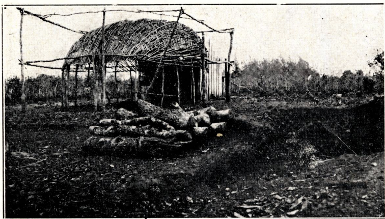
Esqueleto o armazón de uno de los clásicos barbacuás para la desecación de la yerba; en la parte anterior a la derecha, en una excavación, se nota la boca por donde se hace fuego, desembocando el conducto en el centro del barbacuá en forma de chimenea. La yerba se coloca sobre la bóveda del enrejado y un hombre la revuelve continuamente.
