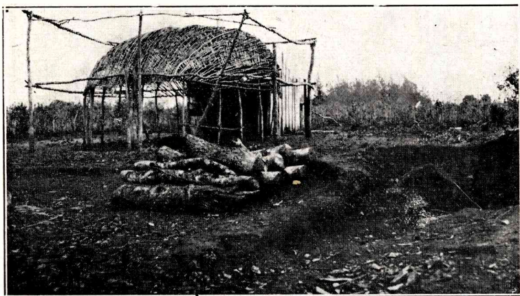
Esqueleto o armazón de uno de los clásicos barbacués para la desecación de la yerba; en la parte anterior a la derecha, en una excavación, se nota la boca por donde se hace fuego, desembocando el conducto en el centro del barbacué en forma de chimenea. La yerba se coloca sobre la bóveda del enrejado y un hombre la revuelve continuamente.
