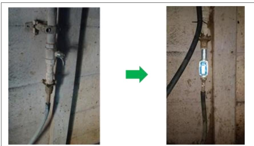
**Figura 10** Caudalímetro instalado en el circuito de agua para lavado de pisos y corrales.
