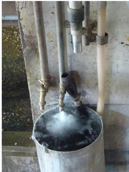
**Figura 9** Rebalse en tanque de almacenamiento de agua para lavado de máquina de ordeño.
