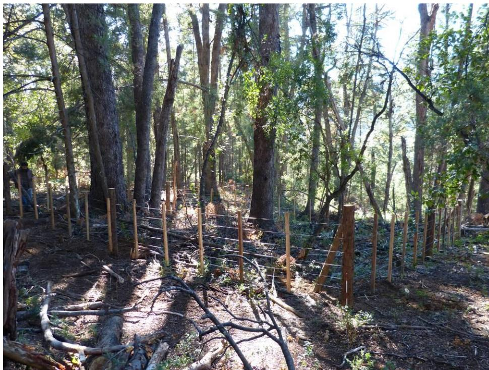
Figura 4.1. Imagen de una clausura recién instalada de 11 m x 11 m, construida con seis hilos de alambre galvanizado, postes cada 5 m y varillas cada 1 m.
