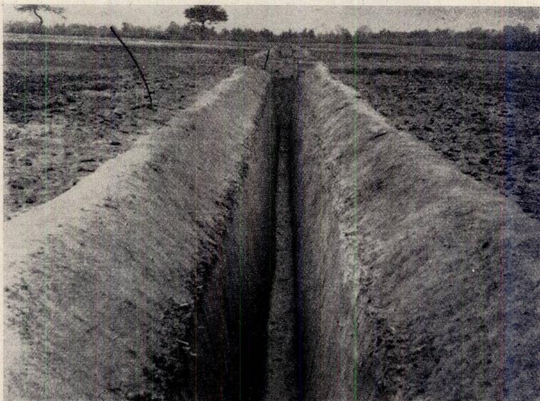
«Drenes» principales en el ensayo de corrección de suelos salinos en La Banda
