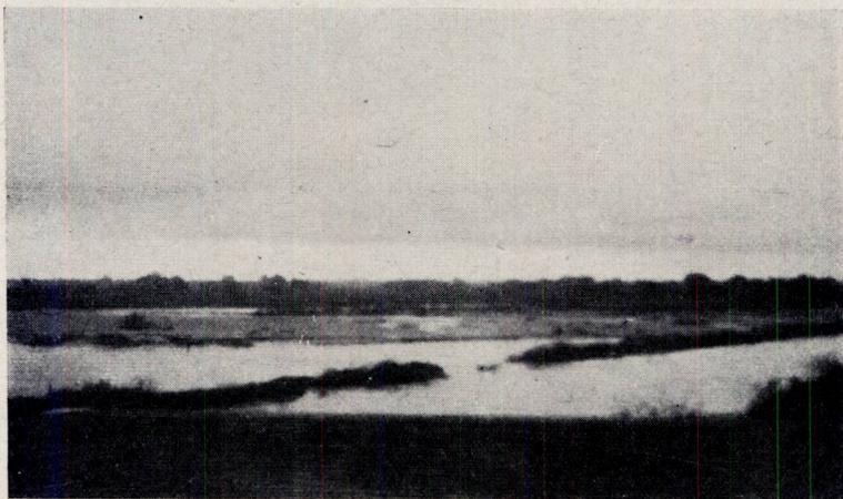
Dique de ramas interpuesto en el curso del Río Dulce y por medio del cual es alimentado el canal maestro que conduce las aguas hasta «La Dársena» o repartidor. Obsérvese el vertedero de descarga que devuelve al río el exceso de agua.
