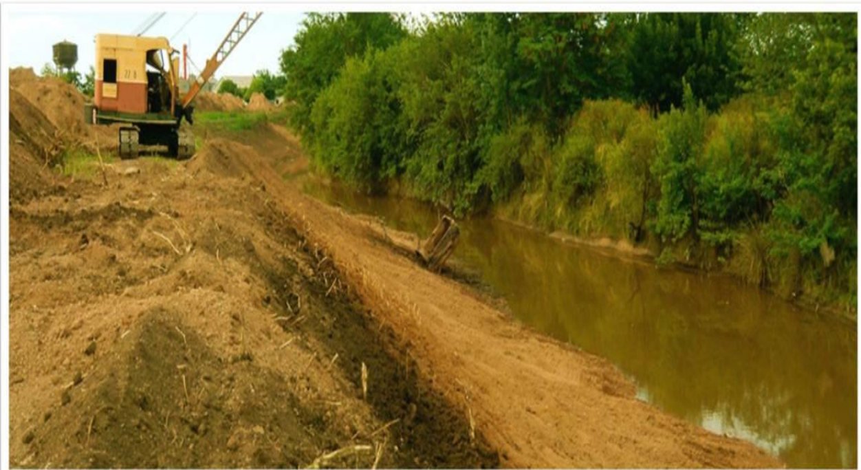
Obras de dragado de arroyo colmatado por sedimentos. Dirección de Hidráulica. Entre Ríos
